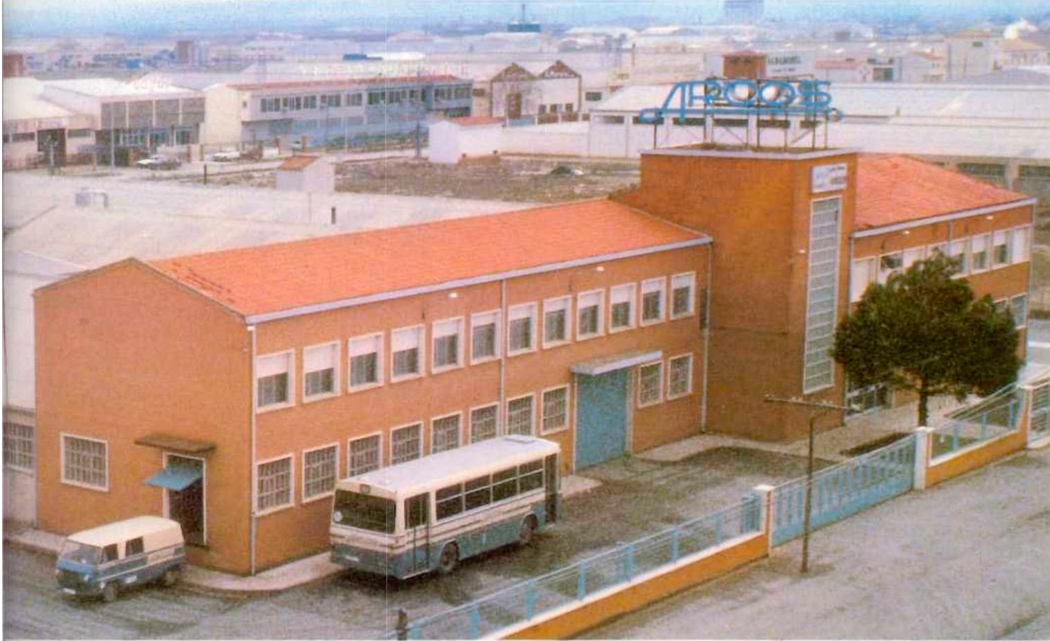
Fabrica de Arcos en los años 80' // Arcos Factory in the 80's
